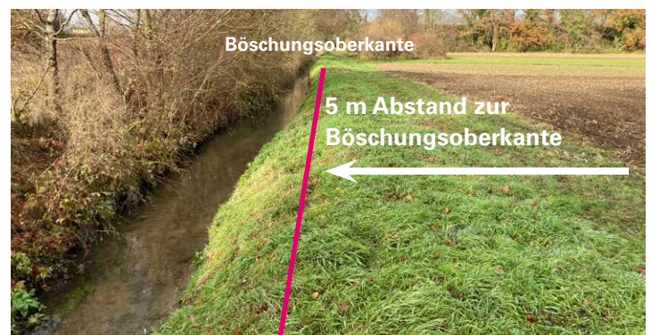
Feststellung des 5 m Bereiches zur Böschungsoberkante
